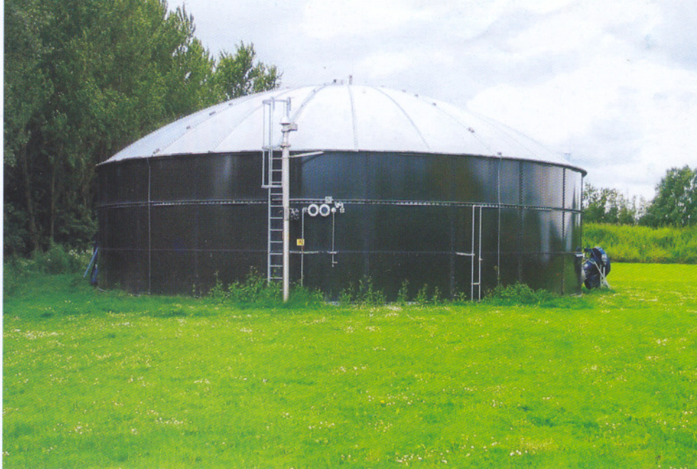
Централа за производство на биогаз от хранителни и селскостопански отпазъци, Биелендорф, Германия
