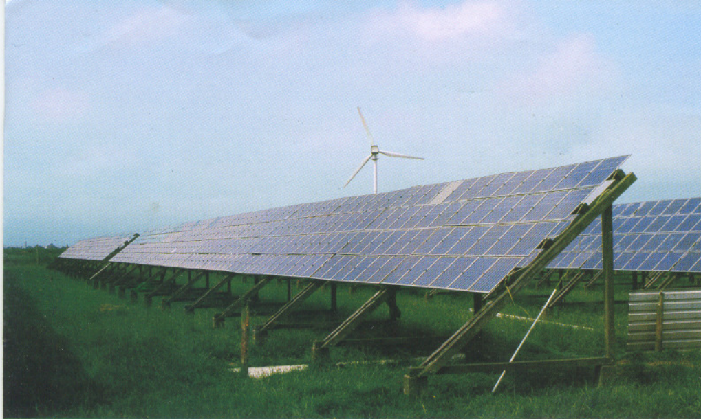
“Остров Пелворм”, Германия, напълно задоволява енергийните си нужди чрез ВЕИ - зимата се произвежда енергия основно от вятъра, а през лятото от фотоволтаични слъчеви панели.
